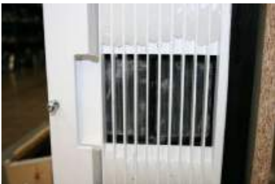
Abbildung 16: Abdichtung am Ablufteintritt
